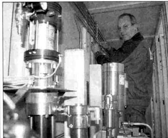
Service-Techniker Ulrich Michalowski montiert eine Anlage. Die Komponenten werden mit selbst entwickelter Software gesteuert.
